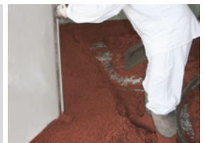
Lehren (Faschen) schütten, verdichten und auf Niveau abziehen
