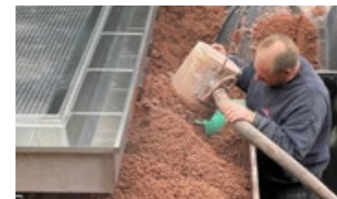
Hinterfüllung mit Poolbock
