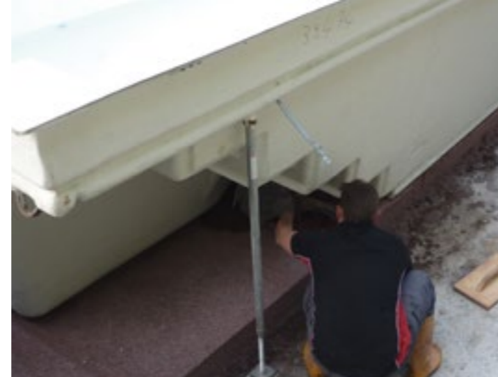
pooltec® WAND Premium Hinterfüllung unter Stufenbereich
