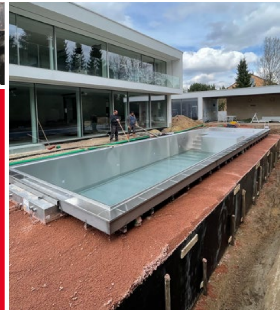
Becken mit Schalung und pooltec® WAND Premium Hinterfüllung
