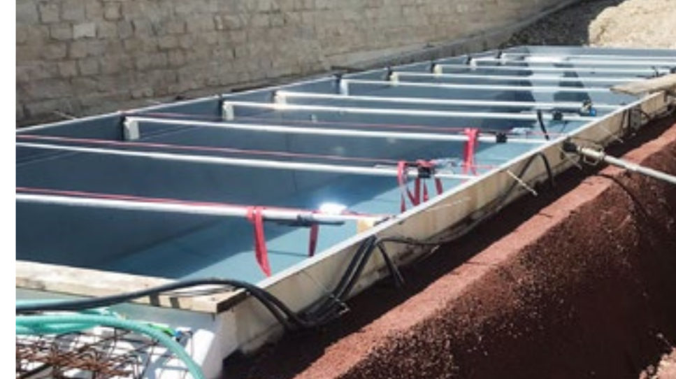
pooltec® WAND Premium Hinterfüllung mit korrekt ausgespanntem Becken
