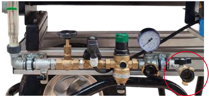
Reinigung des Mischrohrs und der Mischwelle.
